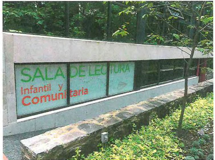
Colocación de viniles en ventanales
